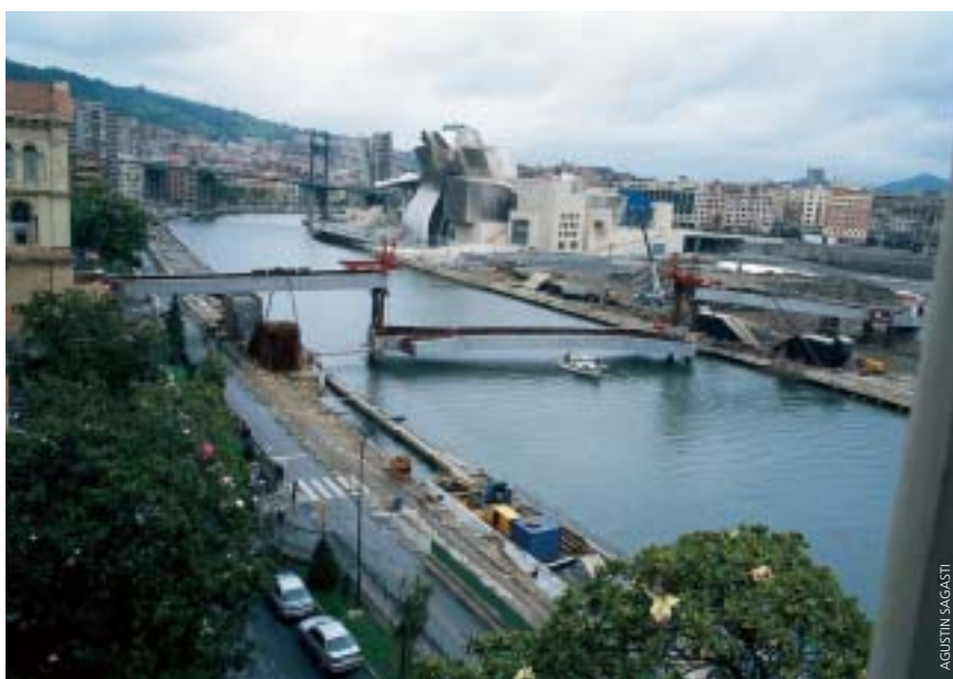
Un momento de la colocación de la nueva pasarela Pedro Arrupe
