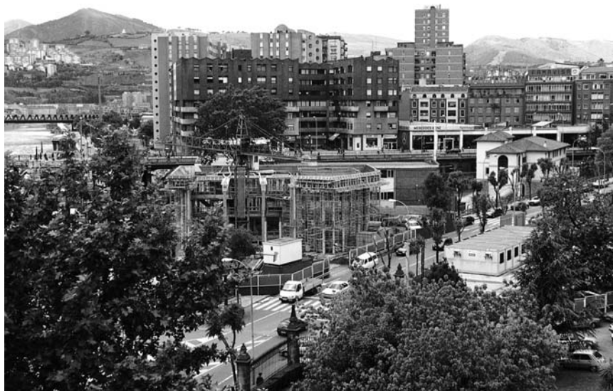
Vista del denominado Edificio de Explotación, punto de entrada al sifón de la Universidad
