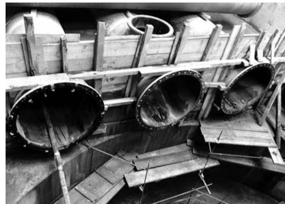
Parte de la obra que se está realizando por debajo de Deusto
